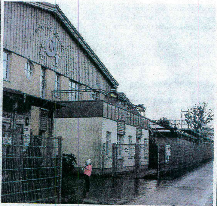
Der Anbau (im Hintergrund) schreitet zügig voran. Foto: F. Gildhorn
